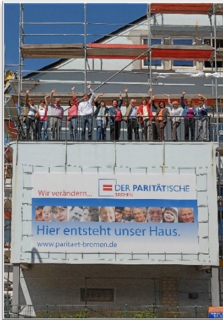
2009: Das neue Verbandshaus entsteht (Bild: Kerstin Rolfes)
