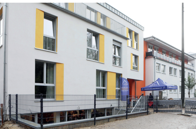
Der letzte Bauabschnitt ist fertig. Foto: Walter Gerbracht
